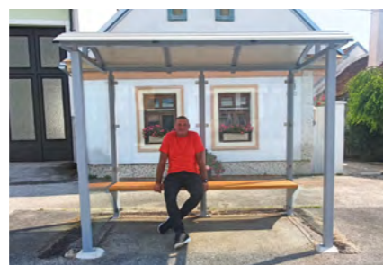
Die vier Bushaltestellen in Steinberg und Dörfli wurden mit modernen Warthäuschen ausgestattet
