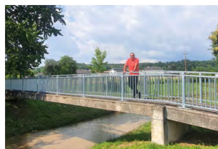
Die Brücke von der Mühlwiesengasse Richtung Sonnriegel wurde mit einem neuen Geländer versehen
