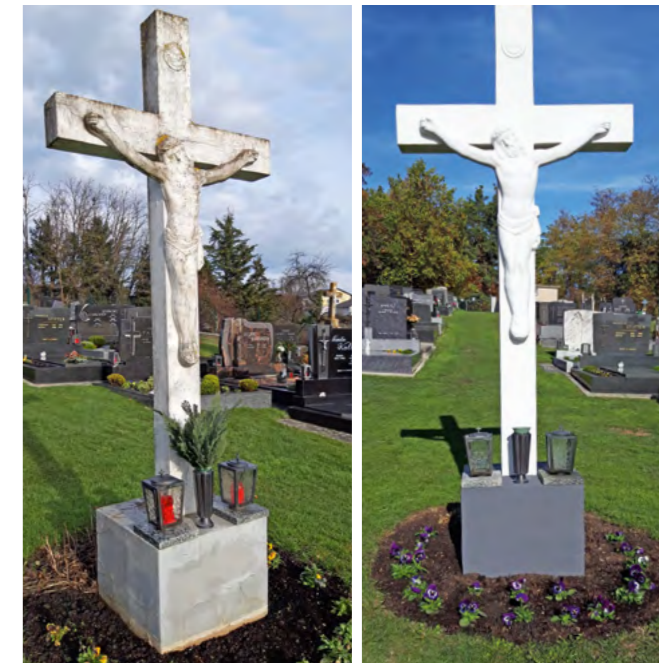
Das Friedhofskreuz in Dörfel wurde saniert
